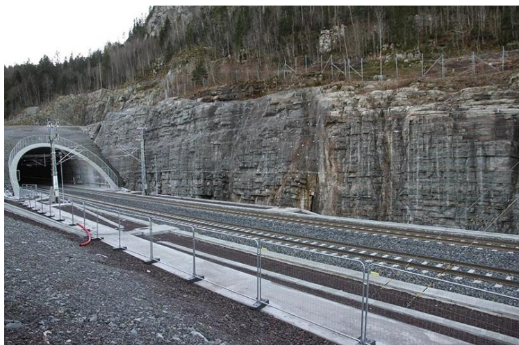
Tunnelinnslaget på Holm
